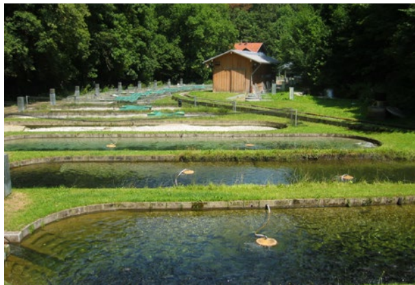
Abbildung 18: Eine Forellenteichanlage. Bildquelle: LfL, Institut für Fischerei, Starnberg
