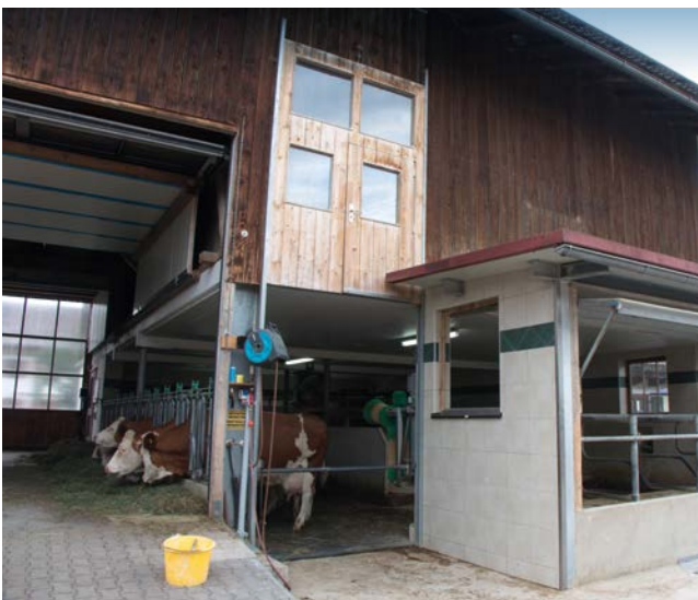
Abb. 6 und 7: Selbst konzipierte Hubtore erleichtern das Entmisten und den Viehtrieb. Quelle: M. Riebe
