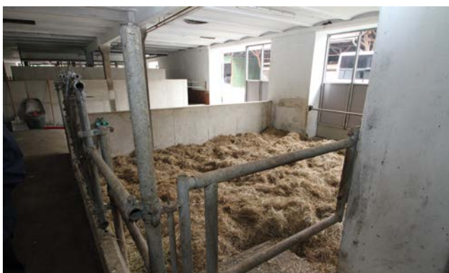
Abb. 17: Der direkte und witterungsgeschützte Zugang des Stalles vom Wohnhaus aus erleichtert die Tierkontrolle im neuen Abkalbebereich. Quelle: M. Ziron
