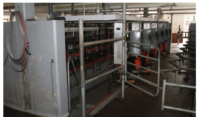
Abb. 18: Trockenen Fußes zum Melkstand; durch die Anbindung zum Wohnhaus auch an regnerischen Tagen angenehm. Quelle: M. Ziron
